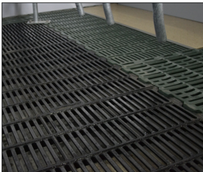
podłoga w kojcu porodowym oparta o ruszty plastikowe i żeliwne
