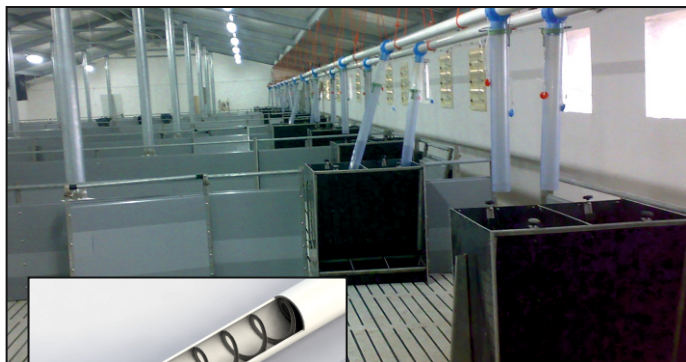
tuczarnia wyposażona w spiralny system zadawania paszy
